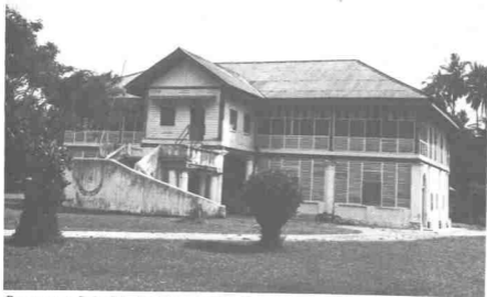
Bangunan Sekolah Kebangsaan Matang Taiping (dahulunya rumah Ngah Ibrahim).
