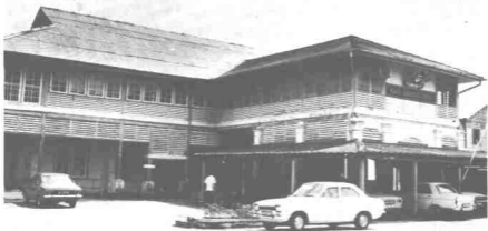
Bangunan Majlis Bandaran Taiping.
